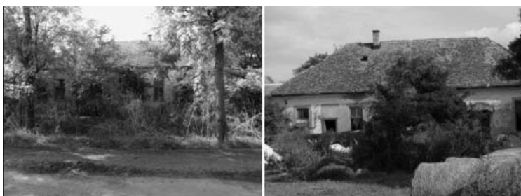
15. kép – A sűrűtanyai iskolaépület jelenlegi állapota (forrás: saját készítésű fotók)
